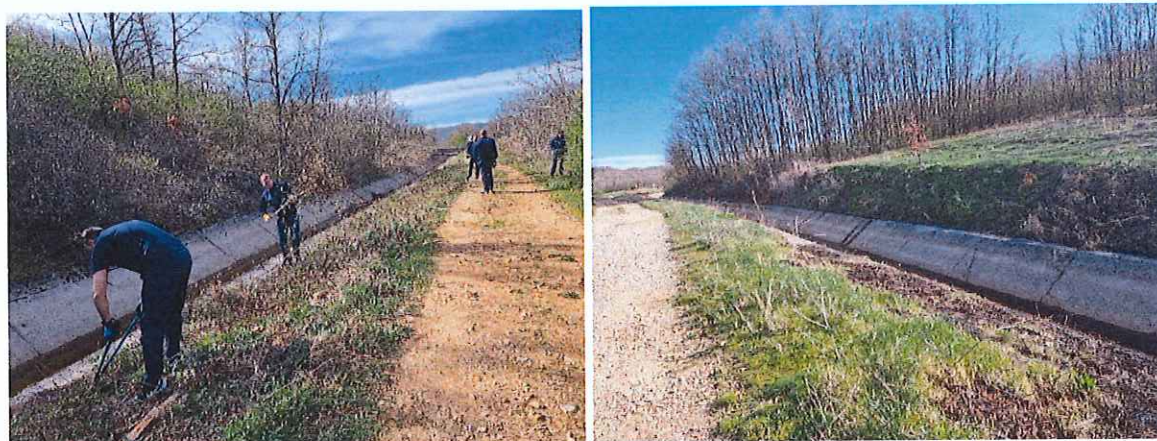
Pastrimi kanalit te hapur, nga lagja e Nishorve deri në Stacionin Pompik Fushtice
